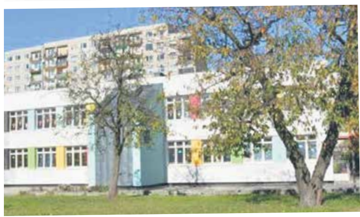
W ubiegłym roku gruntowną termomodernizację przeszło Przedszkole nr 16 przy ul. Korczoka. | Foto arch. UM Zabrze.
