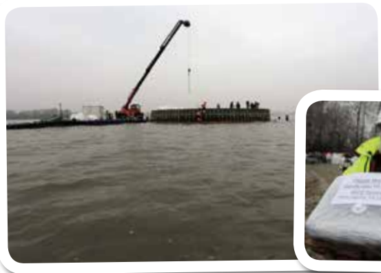
Budowa Ptasiej Wyspy na Jeziorze Goczałkowickim. Na początku grudnia umieszczono w niej Kapsułę Czasu, z przesłaniem dla potomnych. | Fot. arch. WFOŚIGW w Katowicach
