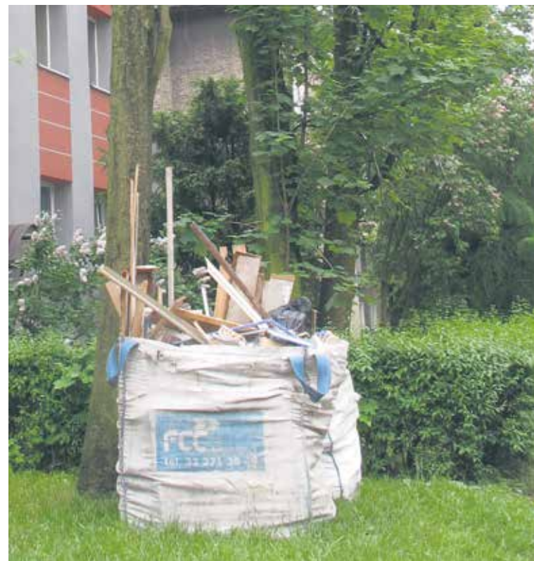
Worki na gruz po remontach. Każdy zabrzezanin, w ramach opłaty za śmieci, może otrzymać worki na 4 metry sześciennie gruzu | Fot: K. Włodarczyk.
