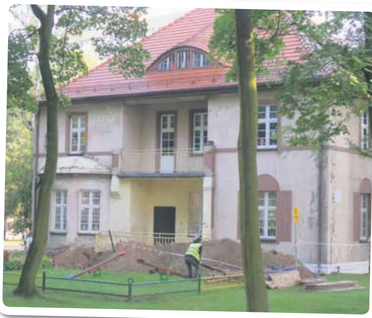
■ Przedszkole nr 19 w trakcie termomodernizacji. | M. Piechowicz-Gruda.
