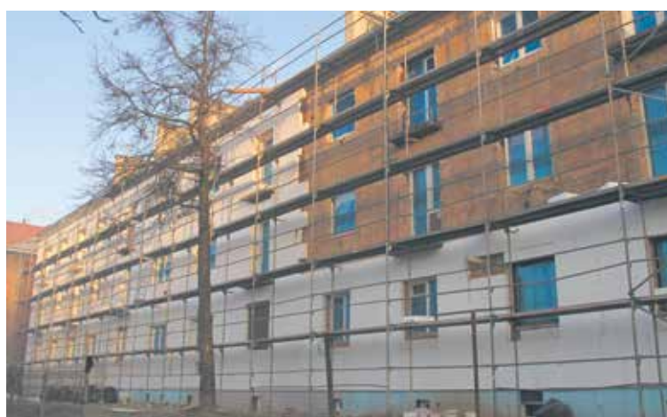
Termomodernizacja w Rokitnicy. Po zakończeniu prac właściciele mieszkań w tym budynku mogą starać się o zwolnienie z podatku od nieruchomości | Fot. K. Włodarczyk.
