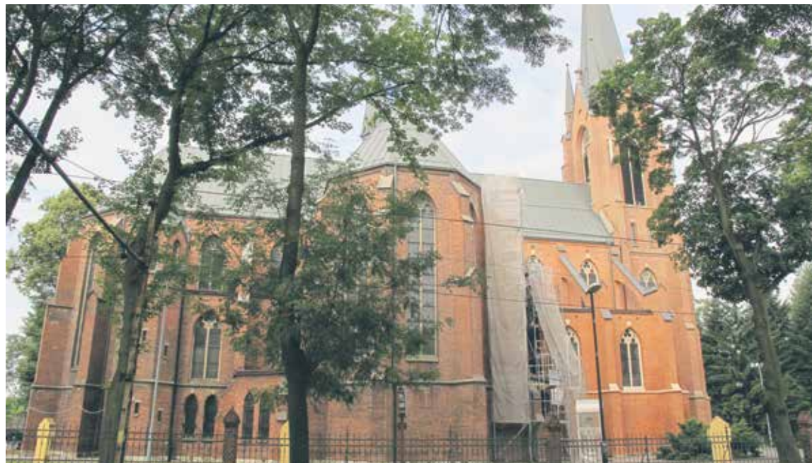
Trwa czyszczenie elewacji kościoła pw. św. Wawrzyńca w Mikulczycach. | Fot. K. Włodarczyk
