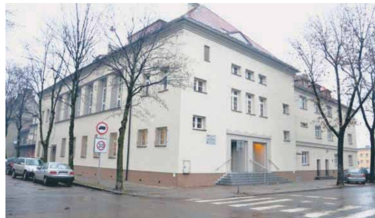
Dzielnicy Ośrodek Kultury w Biskupicach po termomodernizacji. | Fot. arch. UM Zabrze.
