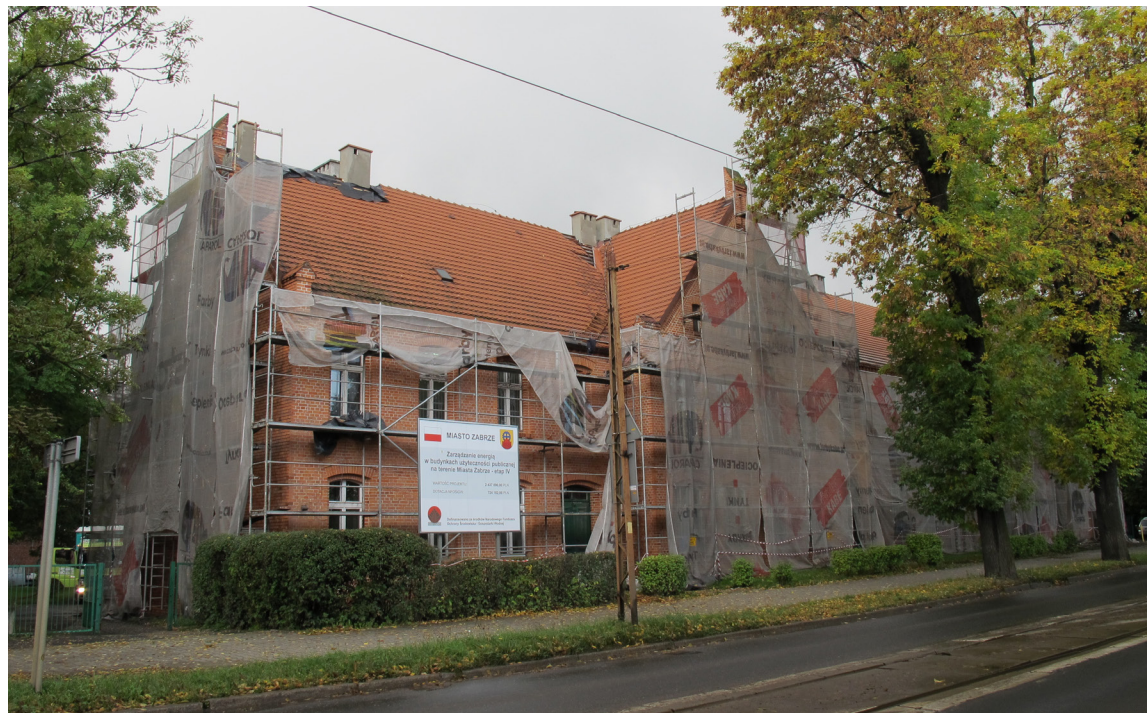
Trwa termomodernizacja budynku Szkoły Podstawowej nr 24 przy ul. Tarnopolskiej w Mikulczycach. | fot. K. Włodarczyk
