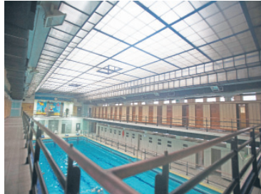
Dach nad Miejskim Zakładem Kąpielowym będzie zupełnie nowy, szklano-aluminiowy, z podwójną szybą. | fot. J. Matuszyńska
