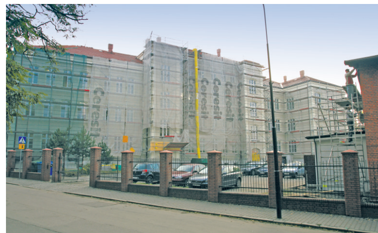
Budynek III LO i Gimnazjum nr 3 podczas termomodernizacji | fot. D. Chrost
